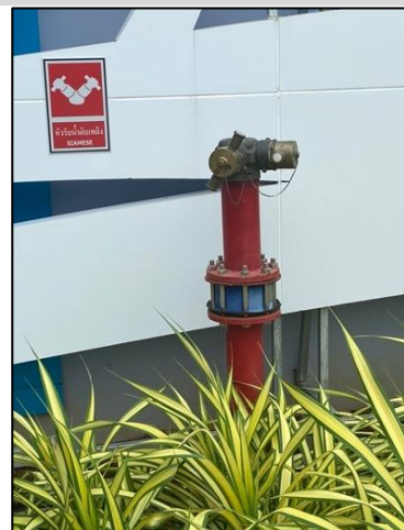
หัวรับน้ำดับเพลิง ขนาด FDC.4"X | 2 1/2"X | 2 1/2" นิ้ว พร้อม Check Valve หัวสวมเร็วและฝาปิด
