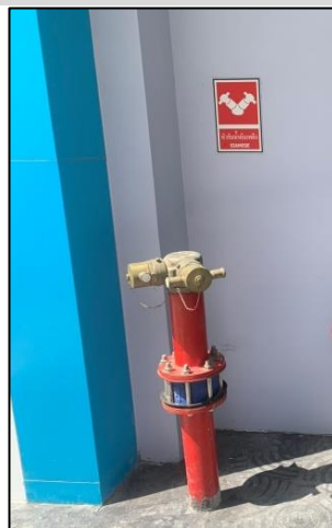
หัวรับน้ำดับเพลิง ขนาด FDC.4"X | 2 1/2"X | 2 1/2" นิ้ว พร้อม Check Valve หัวสวมเร็วและฝาปิด
